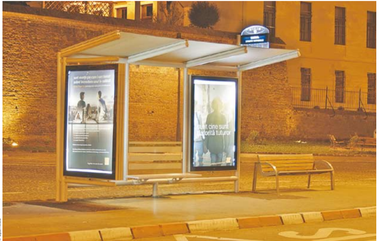
© Epamedia Epamedia Romania im Vormarsch: Buswartegehäuschen, wie jene in Sibiu, werden betreut, neuer Bukarest-Standort wird gesucht.
